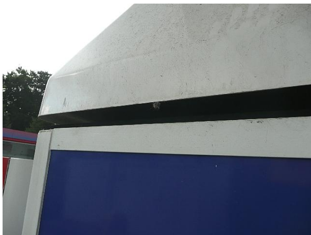
Abb. 2: Containerdeckel kann nicht geschlossen werden
